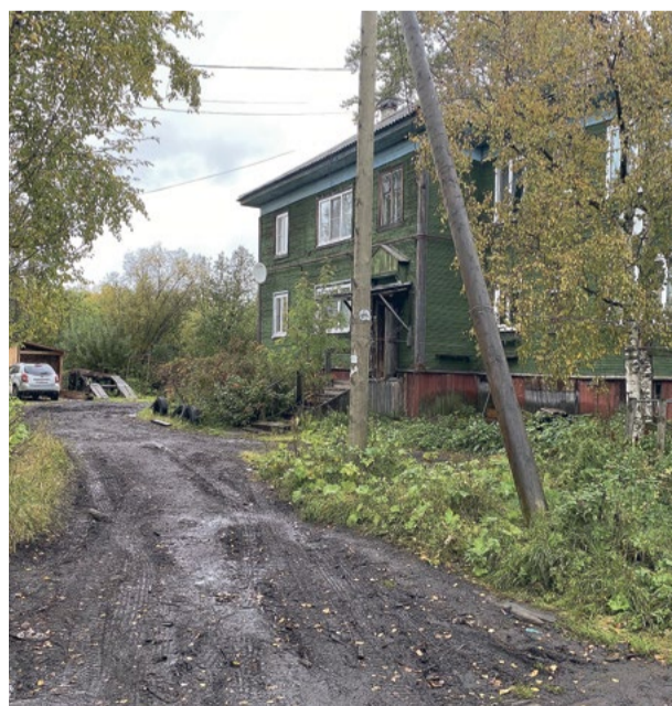
Дороги, ведущие к подъездам, выглядят ещё хуже, чем основная дорога
