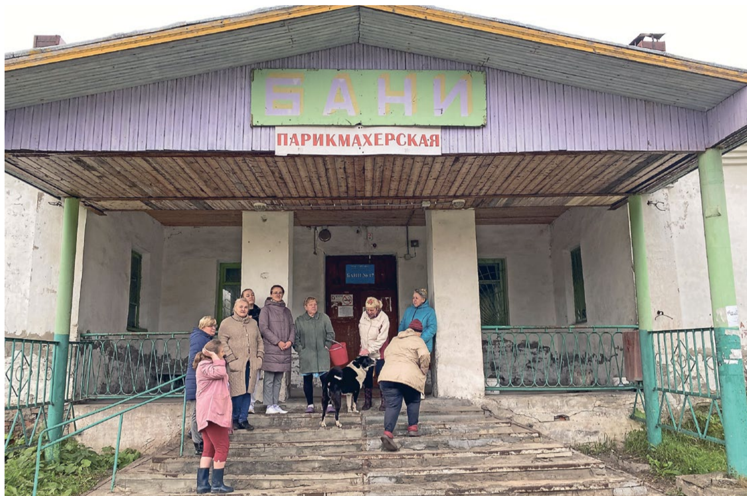
Аварийное здание, в котором сейчас находится отвоеванная в прошлом году жителями посёлка баня. Жители посёлка собрались здесь, чтобы поделиться наболевшим
