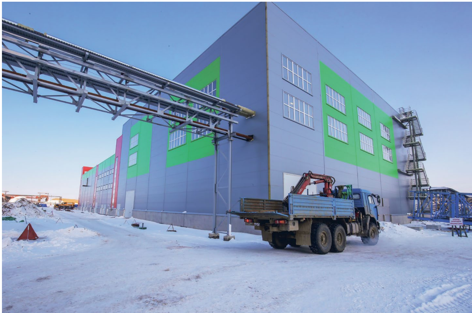
Новый древесно-подготовительный цех готов к работе. Внутри полным ходом идёт монтаж линий для окорки и рубки технологической щепы
