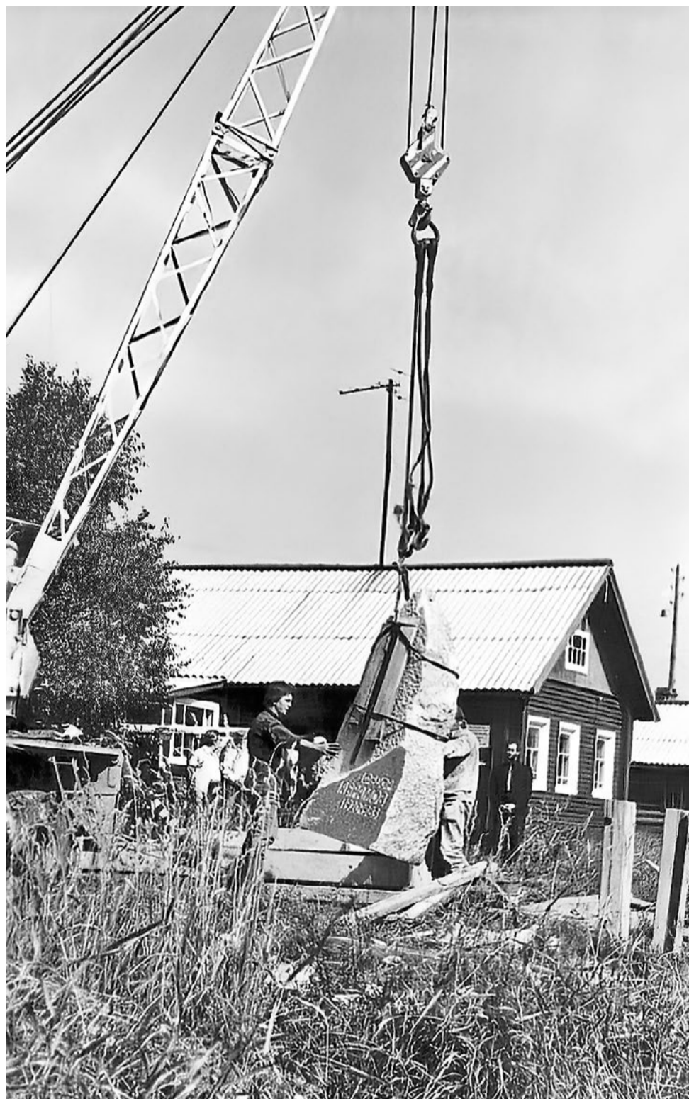
Монтаж памятника. Веркола, 4 августа 1990 г.
