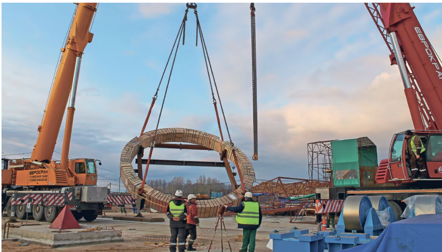
На площадку временного хранения принимают первое опорное кольцо окорочного барабана №1
