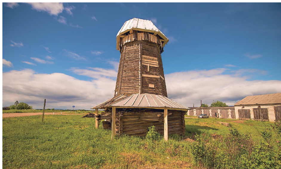
Сейчас мельница-голландка на Ровдиной Горе в аварийном состоянии
