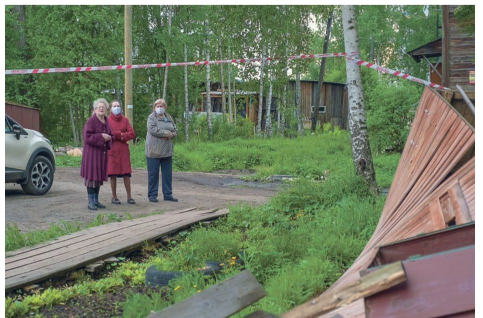
До схода со свай дом неделю трещал
