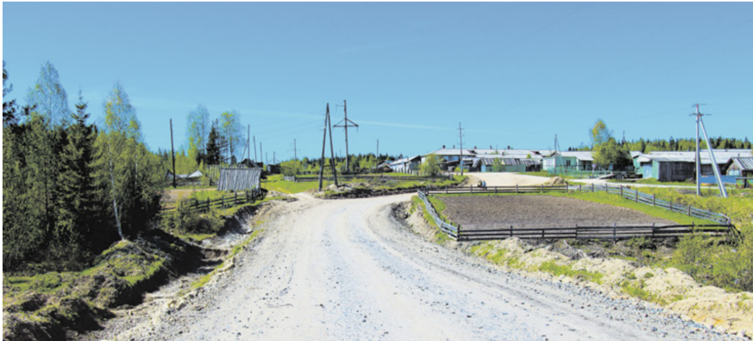
Усть-Покшеньгский леспромхоз обеспечил капремонт, оканавливание и отсыпку песчано-гравийной трассы, ведущей от Ясного к переправе через реку Пинега
