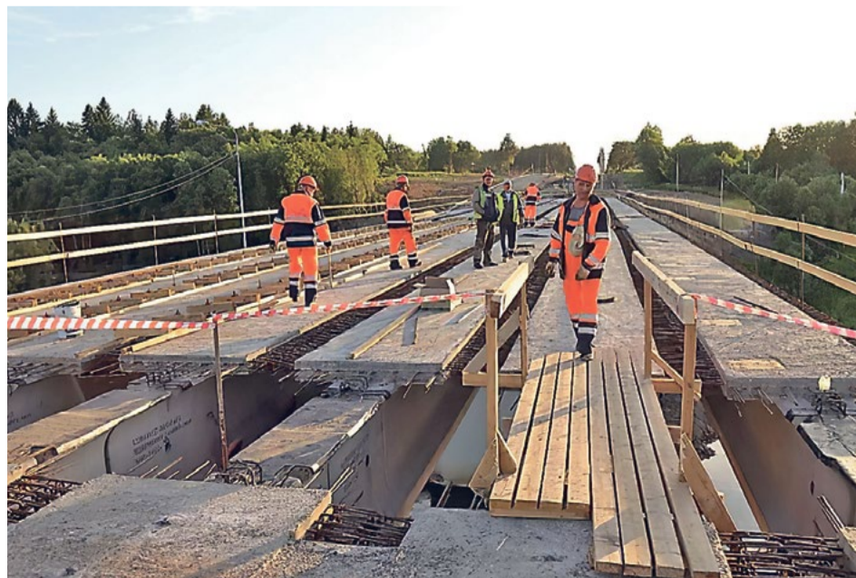
Строящийся мост через Вагу
