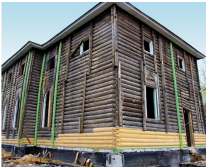
Работы по восстановлению памятника архитектуры регионального значения должны завершиться до 2021 года
