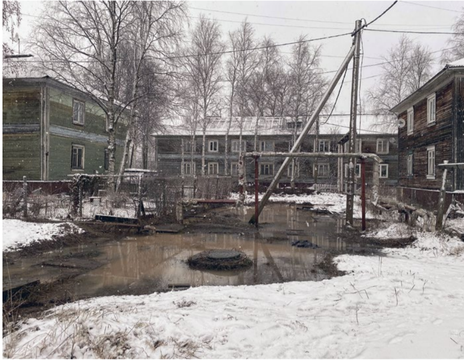
Вот так всё затопило после попытки подрядчика переустановить колонку
